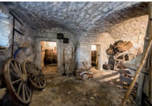
Museumshaus „Haus von Brück“
